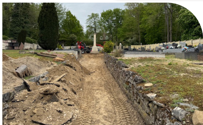
Réfection de l'allée centrale du cimetière
